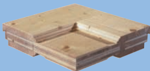
LH-Wohnungseingangstür im Querschnitt
