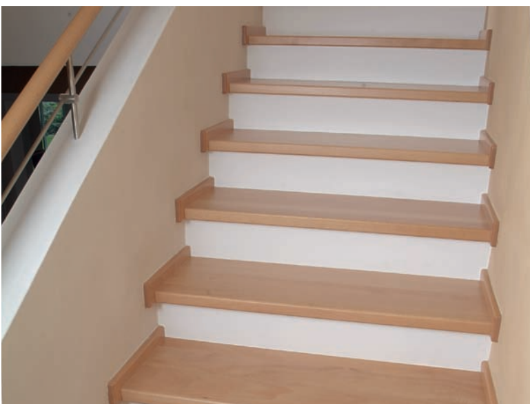
Stufen mit Seitenschutz, Holzart Ahorn
