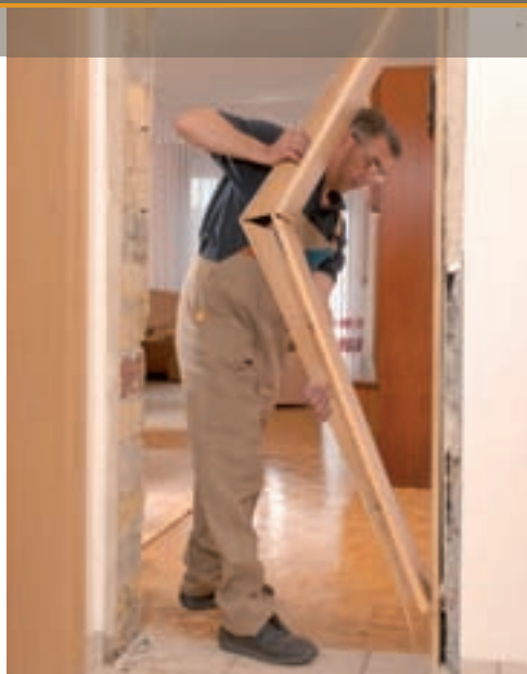
Die alte Zarge wird sauber entfernt.
