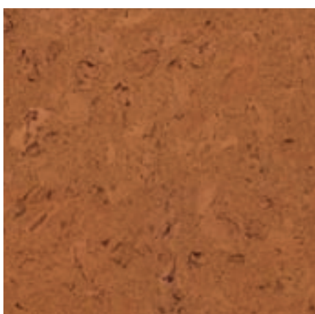
Grosse structure, rouille
